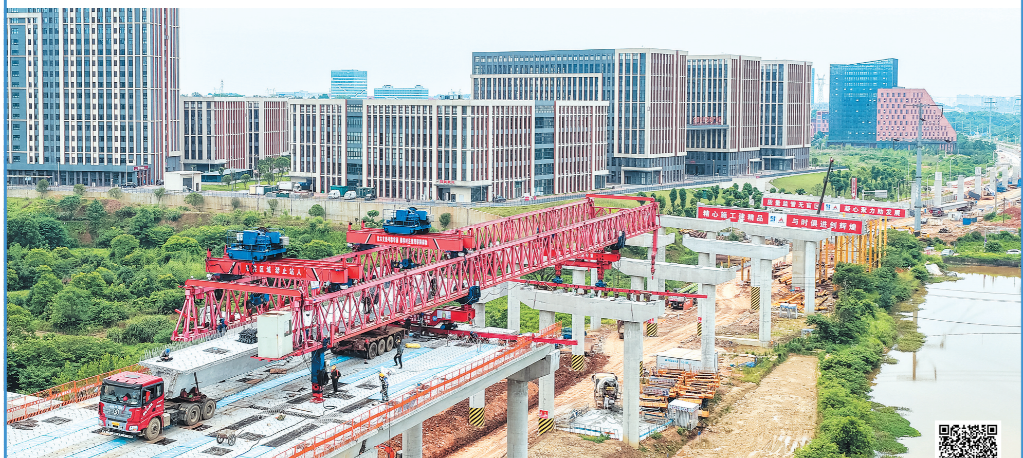
6月12日，位于长沙市开福区的茶绕高速公路中青路1号桥项目，正有序推进预制箱梁架设施工。长沙晚报全媒体记者 黄启晴 摄
