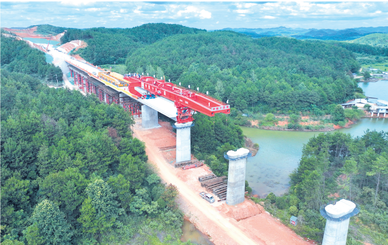
8月1日,铜吉铁路李家湾大桥开始架梁。 通讯员 供图
